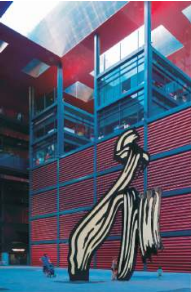
Ampliación del centro de arte Reina Sofía, Madrid, España. Jean Nouvel 2001-2005.
